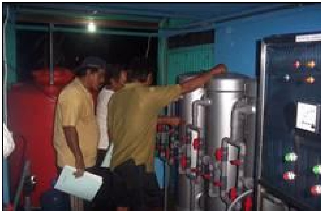
Foto 6 : pelatihan operasional unit pengolah air sistem reverse osmosis pada calon operator.
