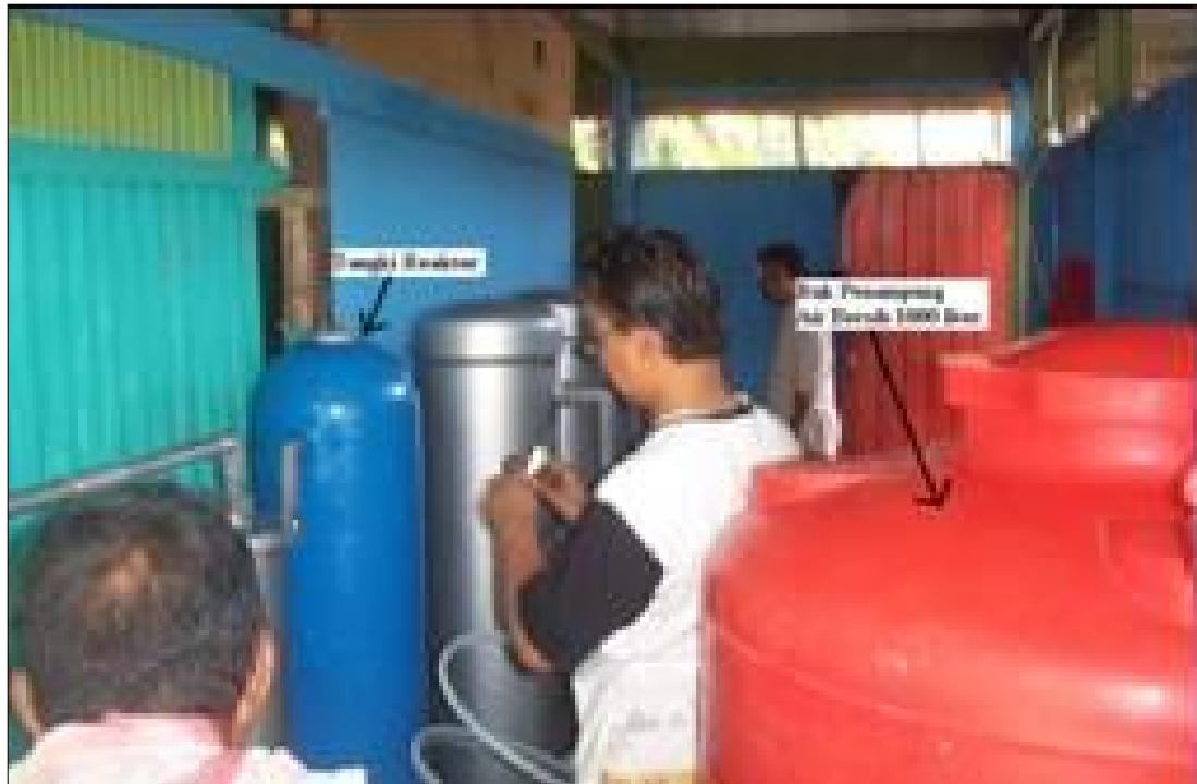
Foto 5 : Tangki reaktor dan bak penampung air bersih volume 1000 liter.
