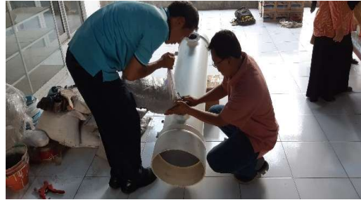
b) Pemasangan Filter Multi Media
