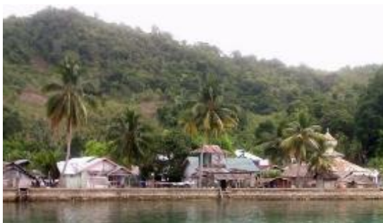
Gambar 13. Potensi bahaya tsunami pada permukiman pantai di Desa Lantibung, Pulau Bangkurung yang di belakangnya langsung berupa perbukitan.
