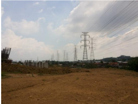
Gambar 13. Kabel transmisi dan lokasi struktur dalam proses konstruksi
