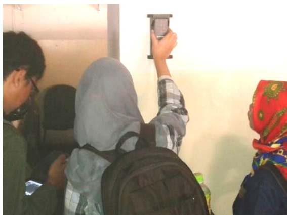
Gambar 3. Pengujian Dimensi Tulangan Baja pada Kolom Beton Gedung Pasar Menggunakan Profometer
