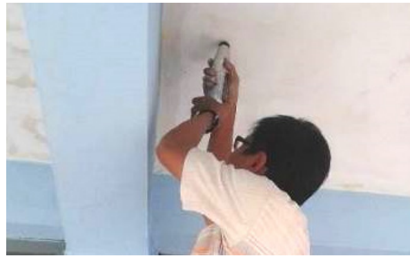
Gambar 5. Pengujian Kuat Tekan Pelat Lantai Beton Menggunakan Hammer Test
