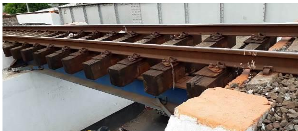
Gambar 10. Jembatan KA 4 Berupa Girder Baja, Bentang 5 Meter
