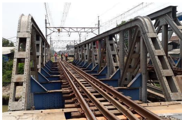
Gambar 1. Jembatan KA 1, Rangka Baja Menggunakan Plate Girder Profile dengan Bentang 25 m
