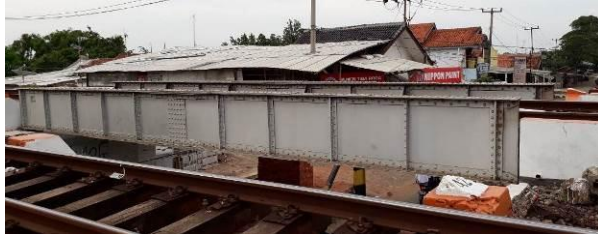
Gambar 8. Jembatan KA 3 Berupa Girder Baja Bentang 12 Meter
