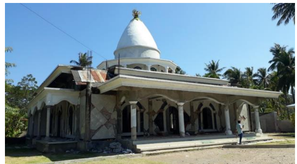
Gambar 3. Struktur Bangunan Masjid Kerandangan
