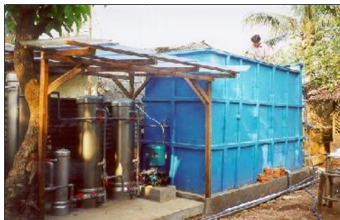
Gambar 14. Kontruksi IPAL Pelapisan Logam Yang Telah Terpasang
