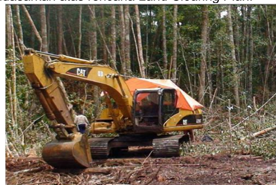
Gambar 4. Clearing & Grubb dengan Eksavator
