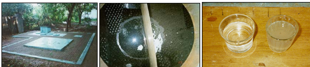
Unit pengolahan air limbah rumah sakit dengan proses Biofilter Anaerob-Aerob. Lapisan mikroorganisme yang telah tumbuh dan menempel pada permukaan media biofilter. Air limbah sebelum diolah dan air hasil olahan.
