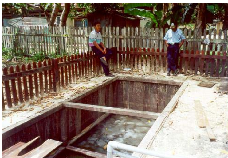
Gambar 7. Bak Penampung Air Baku
