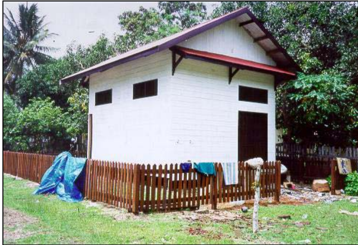
Gambar 5. Bangunan Pelindung Unit IPA-RO
