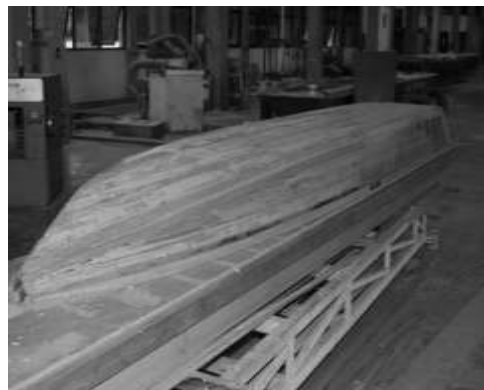
Gambar 1 pemasangan kayu laminasi pada frame
